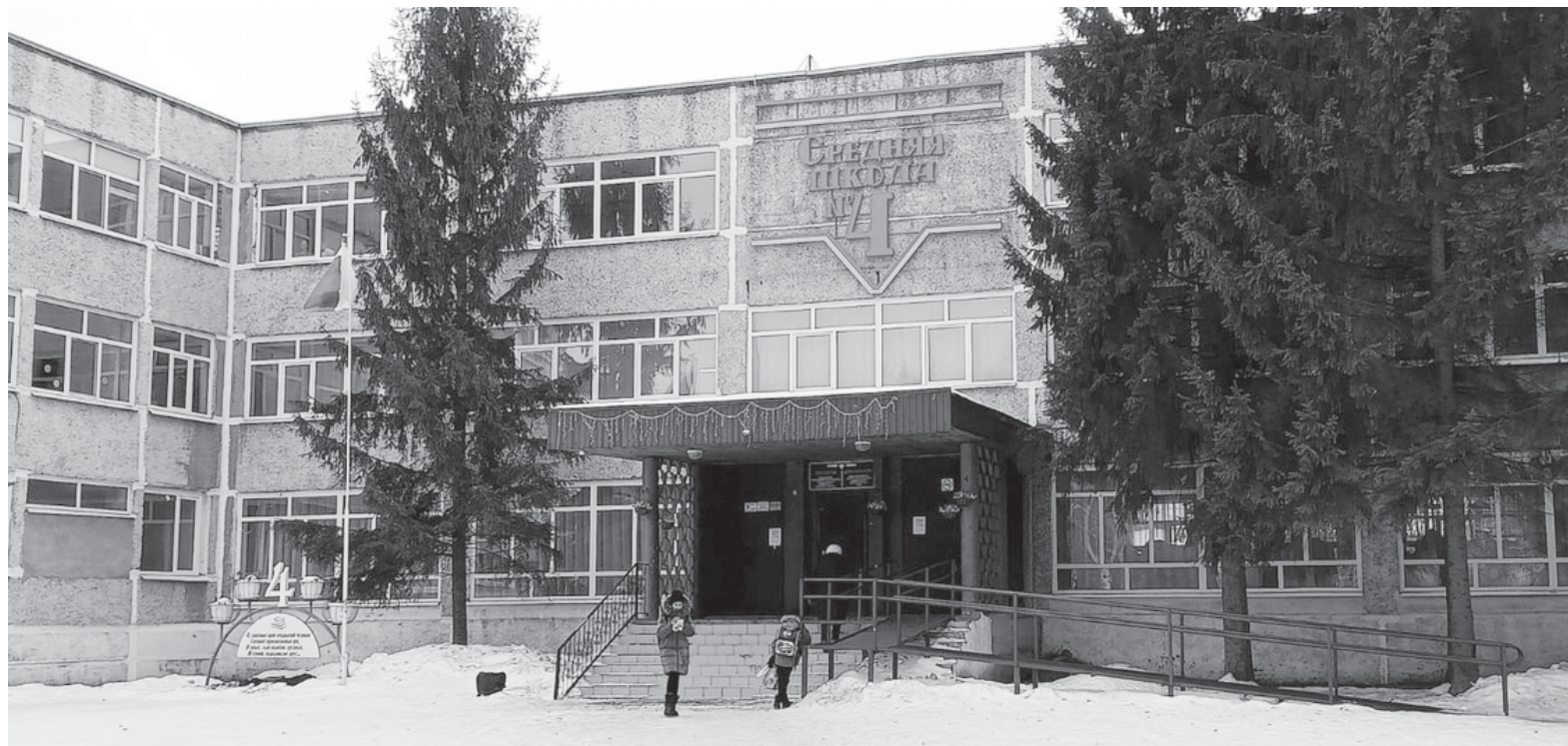
В марте в школе №4 начнется масштабный ремонт.
